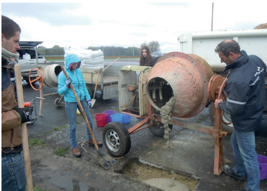
Herstellingen van de gaten in de piste
