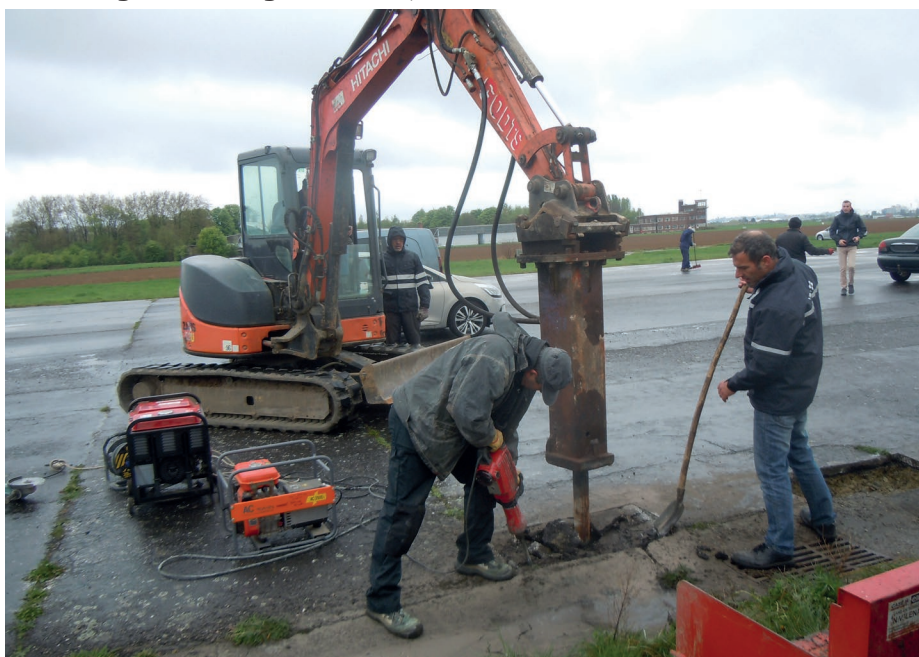
Herstelling van de gaten in de piste
